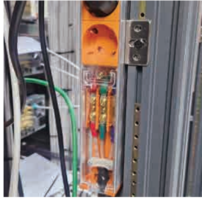
그림 23. 링 터미널 콘센트 / 방송 접지용 부스바 플로팅
