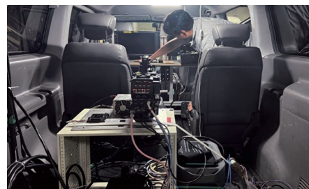
그림 19. 이동 중계차 내부 설치
