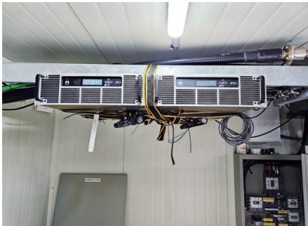
그림 17. 임시송신기 설치
