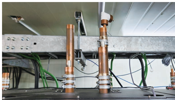
그림 28. 안테나에 리지드 라인 연결 작업
