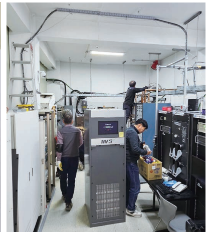
그림 4. 신형 송신기 설치
