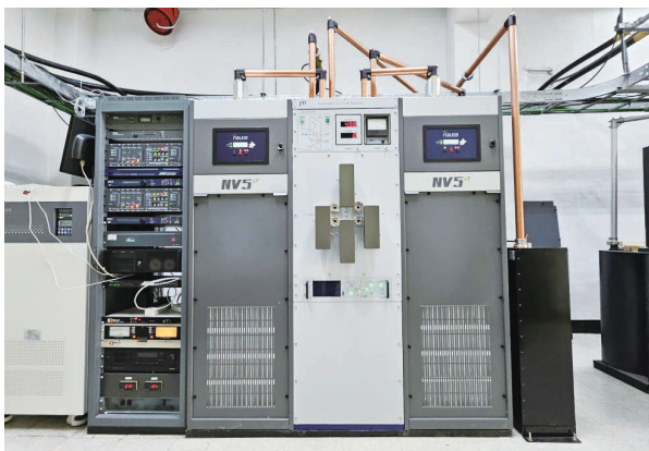
그림 5. NAUTEL 송신기 설치 완료
